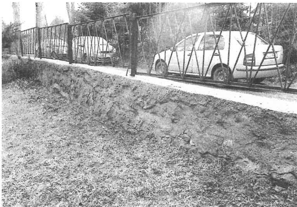
Fot. 12. Runowo, strona północna widoczny mur kamienny w całości zaciągnięty zaprawą cementową.
