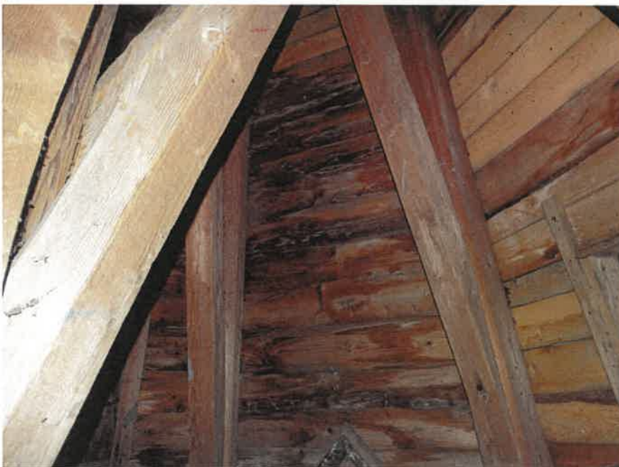
Zdj. 9. Widok deskowania więźby wieży
