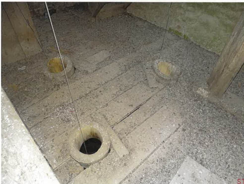
Zdj. 2, 3. Widok stropu międzykondygnacyjnego od spodu i wierzchu
