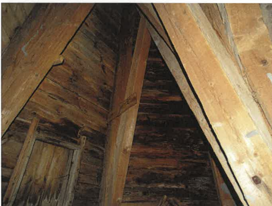
Zdj. 11. Widok deskowania więźby wieży
