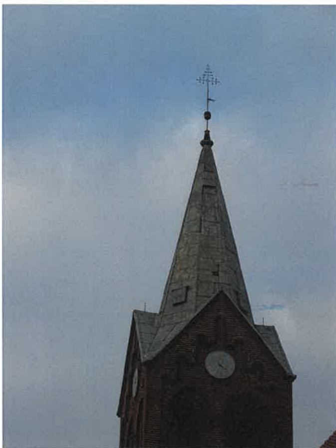
Zdj. 1. Widok hełmu wieży od strony wschodniej
